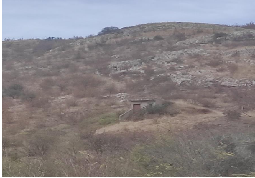
Резервоар за вода
