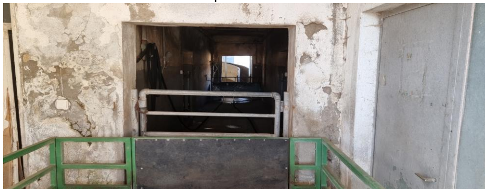
Приемен ходник на сточно депо
