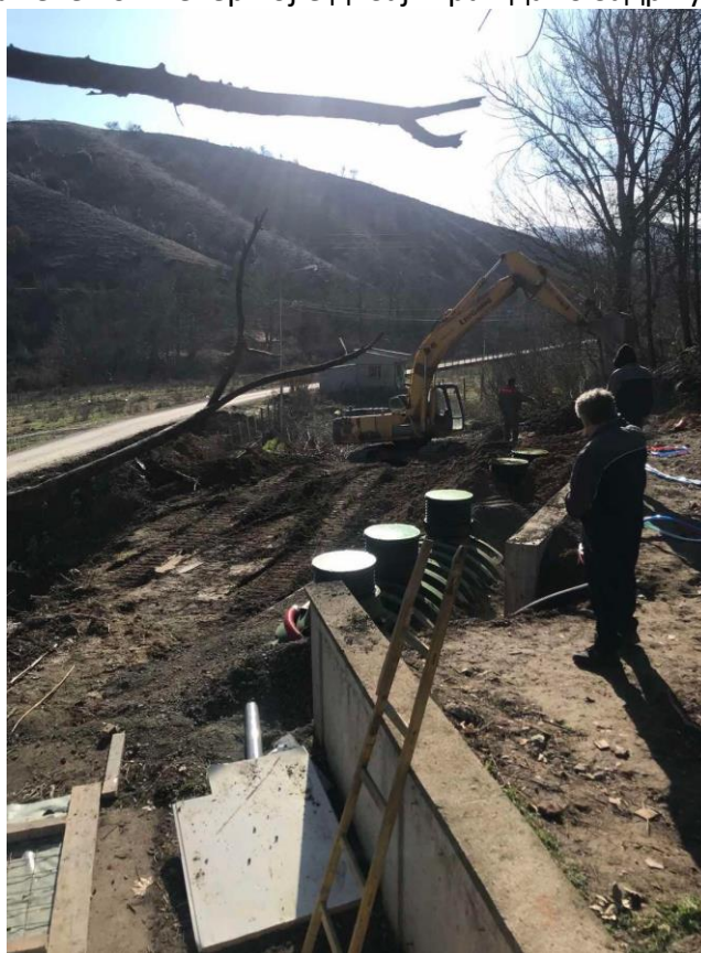
Фотографија од поставување на пречистителната станица
