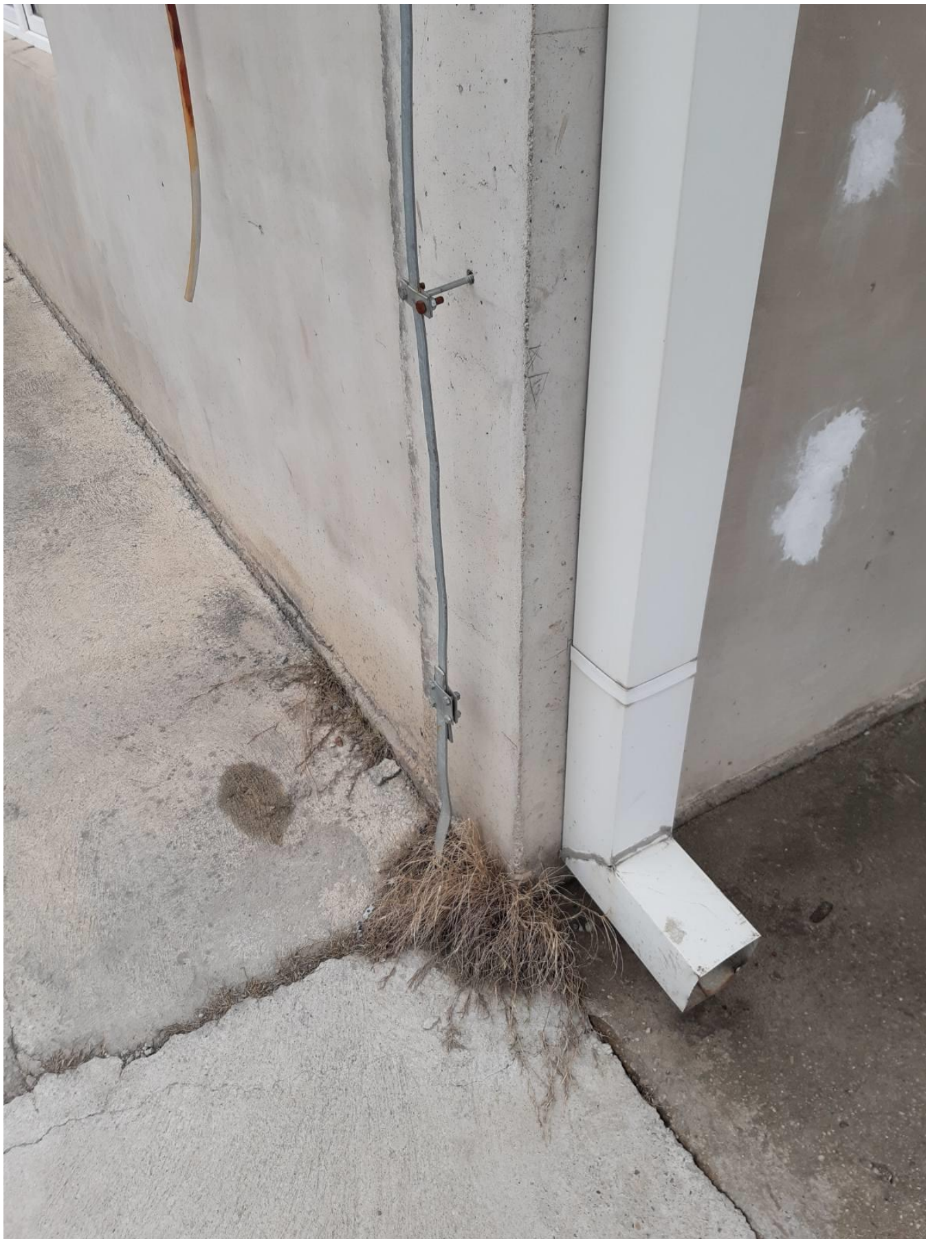
Фотографи од објект и заземјувачки систем на место на вкрстување
